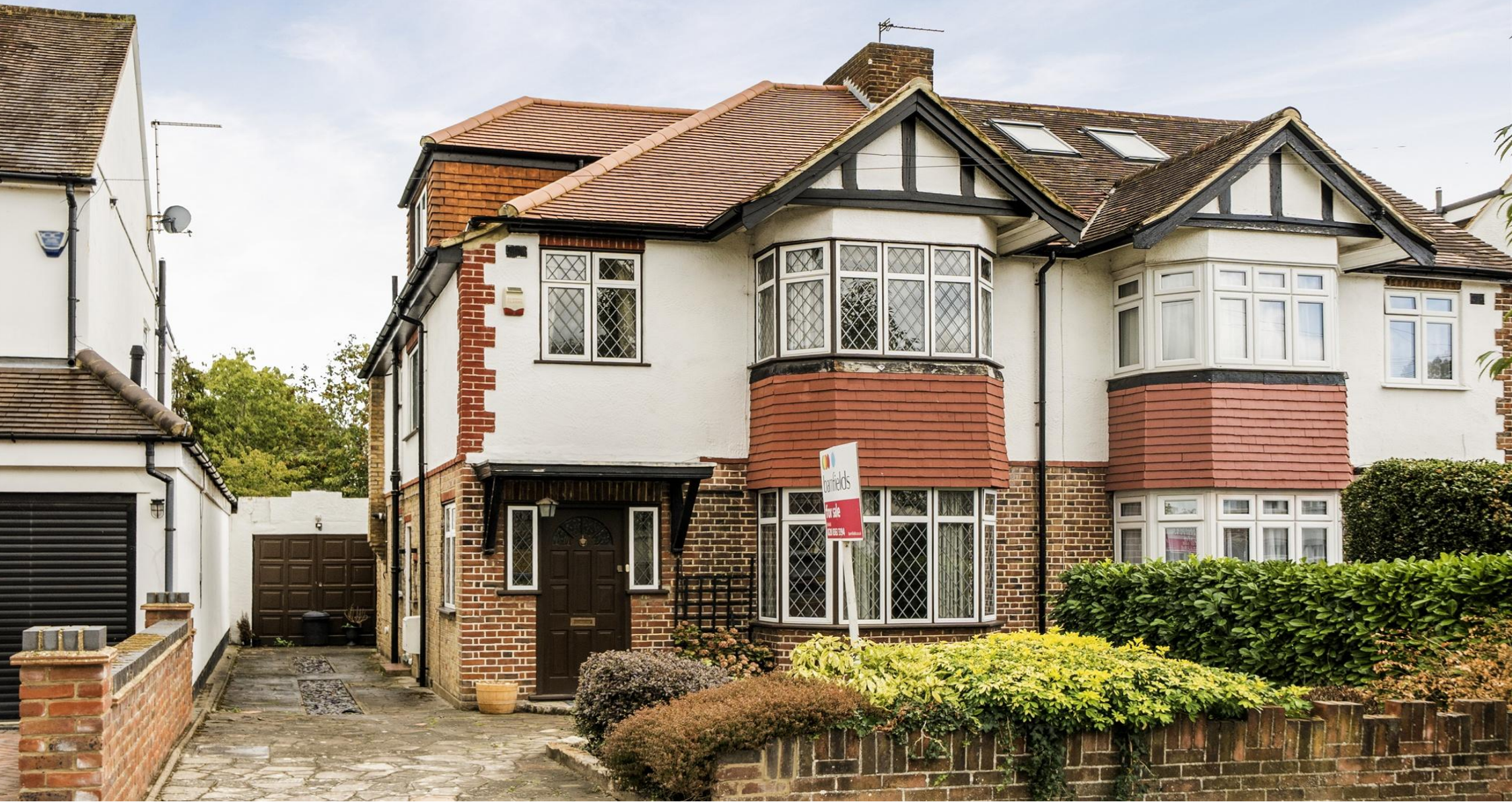
Conway Gardens, Enfield, EN2 9AD
